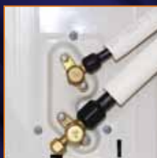
7. Finalisation du raccordement
