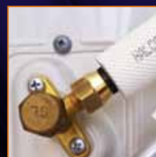
6. Finalisation du raccordement
