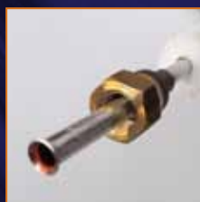
4. Contrôle visuel de la bonne réalisation de l'évasement
