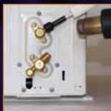
6. Chauffage de la gaine rétractable
