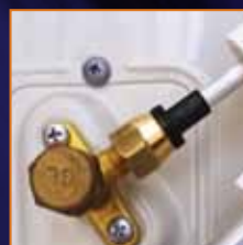
5. Installation du raccord spécifique DUAL (couple de serrage suivant préconisation des fabricants d'unité A/C)
